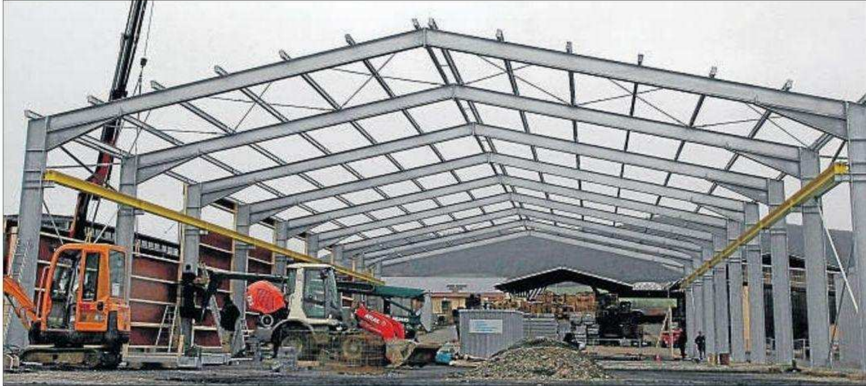
Neubau: Bauhandwerker ziehen die Halle auf dem Gelände der Firma Fehrensens am Grasweg in Hedemünden hoch. Das Skelett mit den stählernen Stützpfählern ist bereits zu sehen. Wenn das Gebäude fertig ist, werden darin hochwertige getrocknete Hölzer gelagert und es wird Holz vermessen. Foto: Kruschmann
