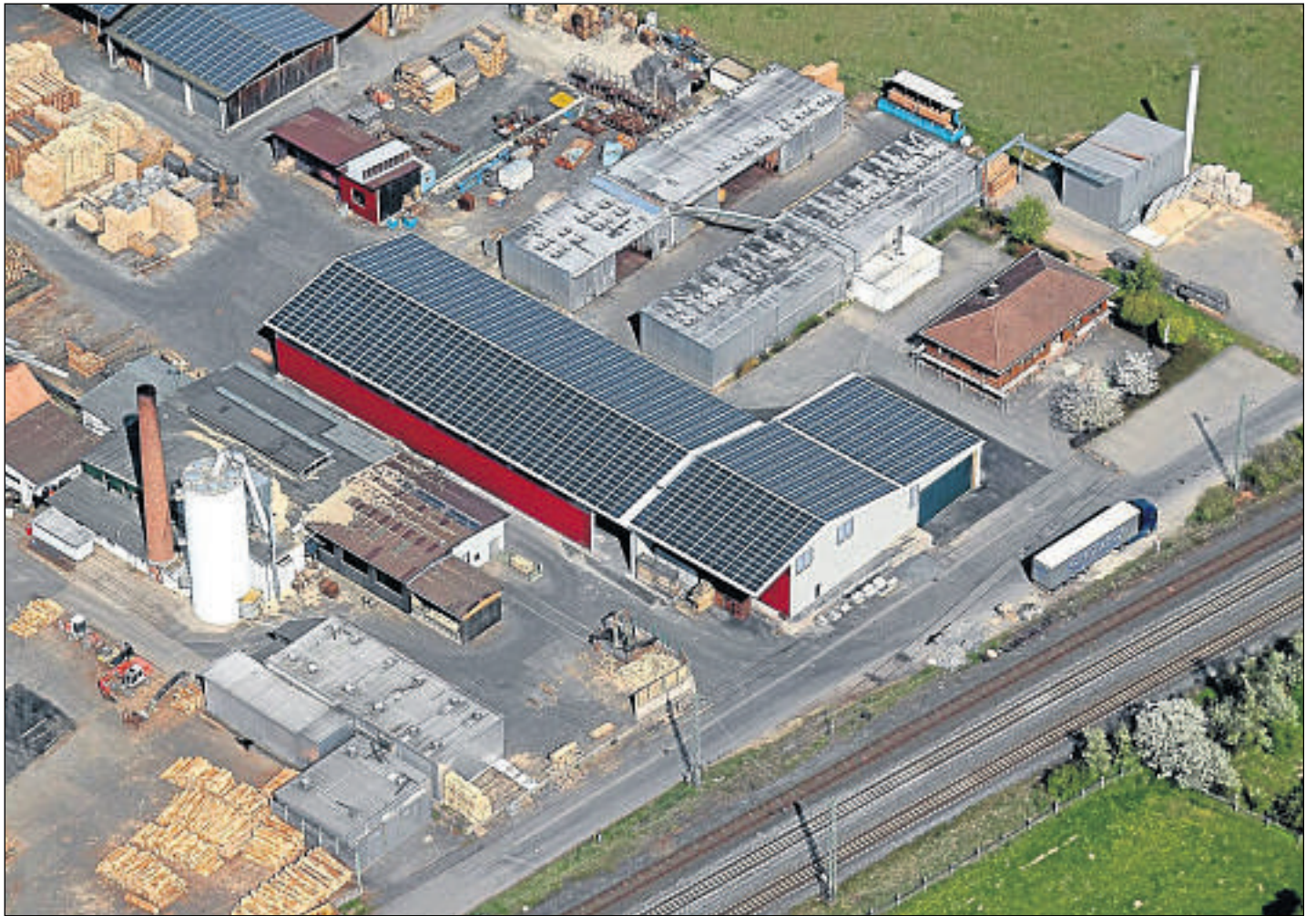
Strom aus Sonnenenergie: Das Luftbild zeigt die riesige Fotovoltaikfläche auf dem Dach der wiederaufgebauten Produktions- und Lagerhalle am Graseweg. Gebäude und die Fotovoltaikanlage waren durch das Großfeuer im August 2010 zerstört worden. Luftbild: Rampfel
